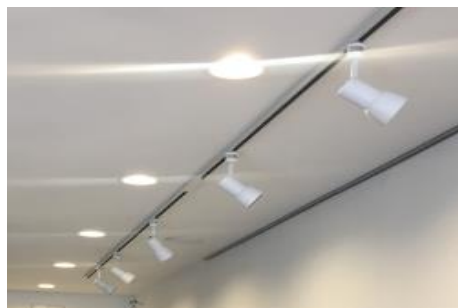
例)室内照明の設置
